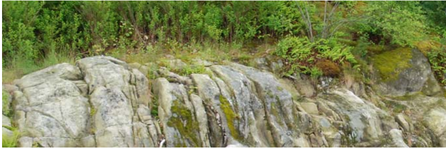
Bergsslänt i anslutning till Thorildsplatsen.
