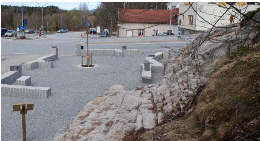
Bergsslänt i anslutning till Thorildsplatsen.
