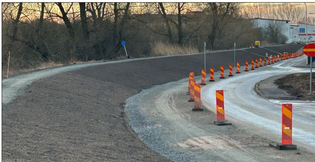
Hedentorpsvallen efter upprustning med gångbana uppe på vallen och cykelväg nedanför. Bild: Kristianstads kommun
