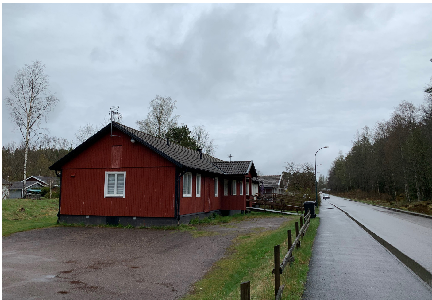
Befintlig byggnad inom planområdet
