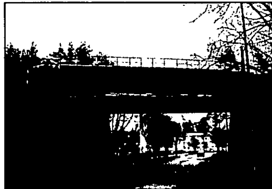
Befintliga järnvägsbroar i stål över Hertig Carls väg, broläge 1
