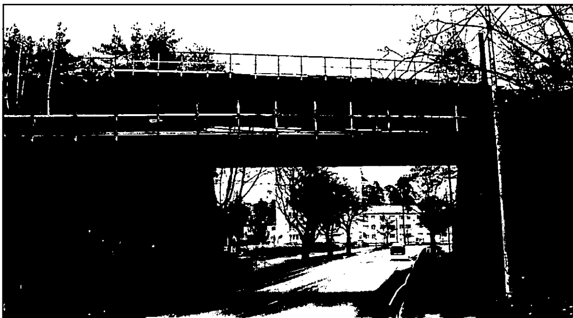
Befintliga broar över Hertig Carls väg, broläge 1. Stålbroarna med dess gamla stödmurar ramar in infarten till bostadsområdet Södra.
