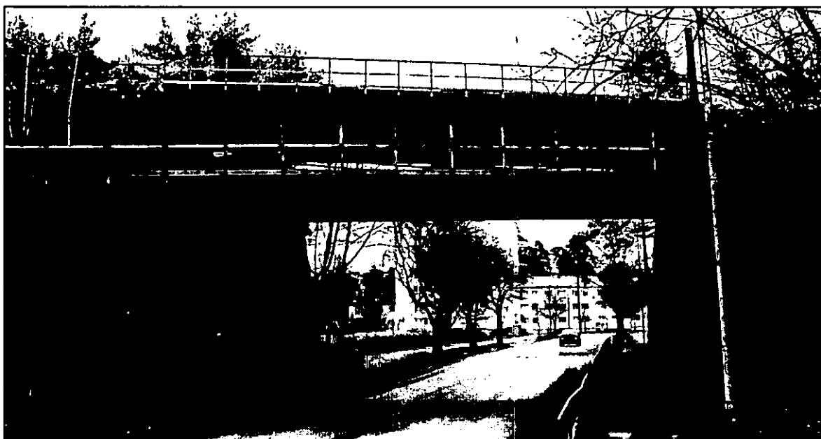
Befintliga broar över Hertig Carls väg, broläge 1. Stålböarna med dess gamla stödmurar ramar in infarten till bostadsområdet Södra.
