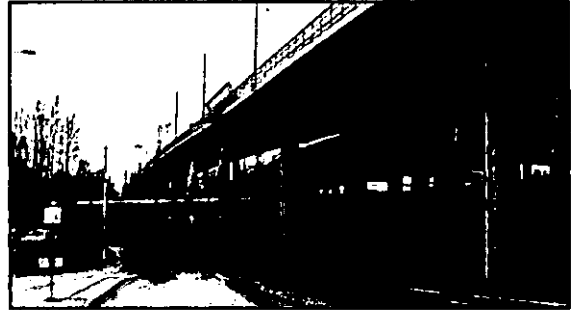
Befintlig järnvägsbro i betong över Hertig Carls väg, broläge 2
