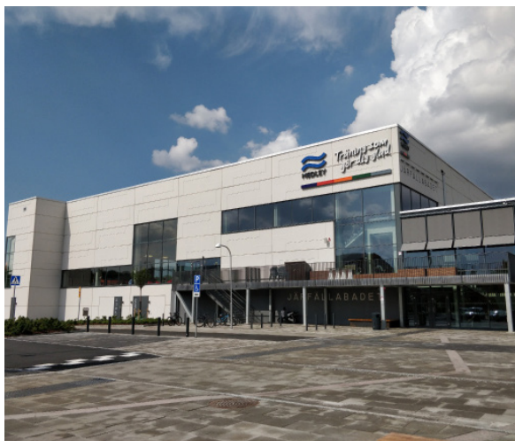
Den nya simhallen och dess entréparti.
