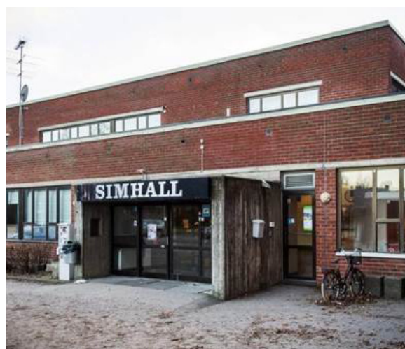
Den äldre simhallen och dess befintliga entré som vetter mot parkeringen i norr.
