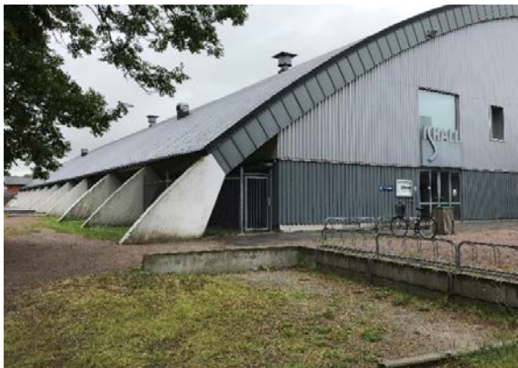
Ishallen, med de synliga betongstöttorna.
