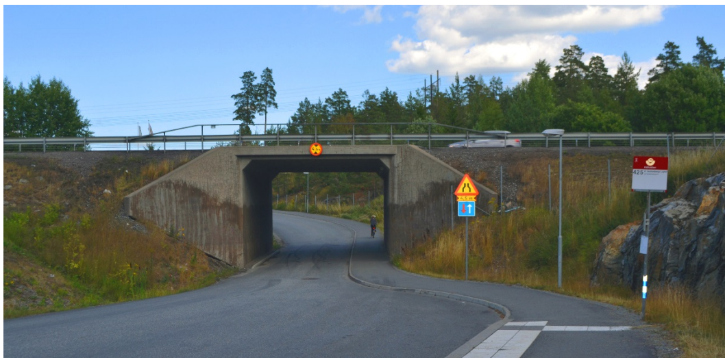
Figur 19: Befintlig vägtunnel för Hålluddsvägen under Värmdöleden.
