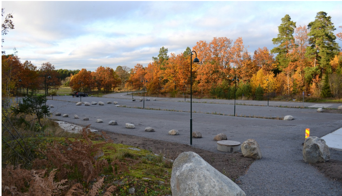
Figur 16: Fotografi av den befintliga parkeringen.
