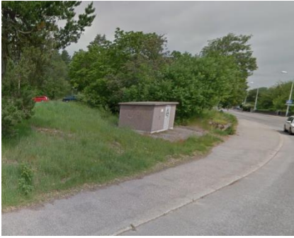
Transformator invid Nysätersvägen
