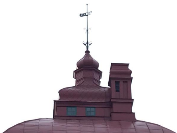
Tornhuv med spira och skorsten allt klätt.
