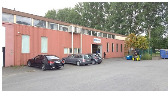
Verkstadsbyggnaden inom fastighetens södra del.
