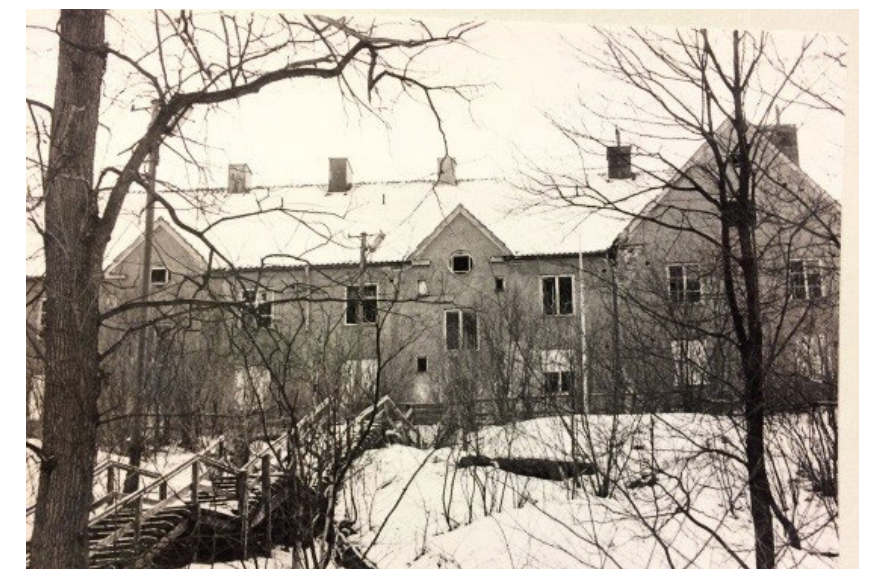
tidigare bostadsbyggnad, nu riven
