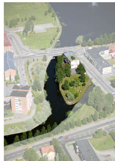
Figur 9 visar vybild över befintlig byggnad från 2005, Bodens kommun. Sedan bilden togs har södra fasaden och fasaden mot Lulevägen på våning 1 försetts med svart plåt.
