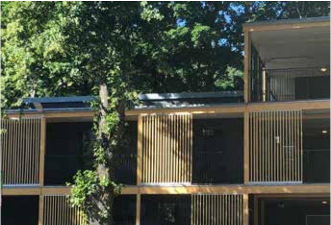
Referens, synligt bärverk
