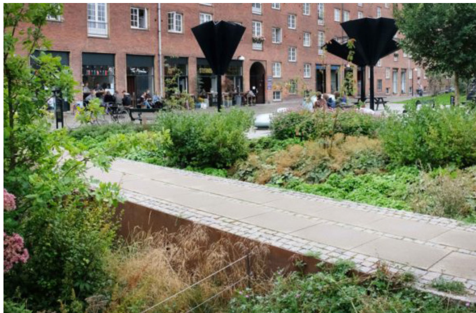
Exempel på dagvattenhantering med nedsänkta planteringsytor. Tåsinge plads, Köpenhamn.
