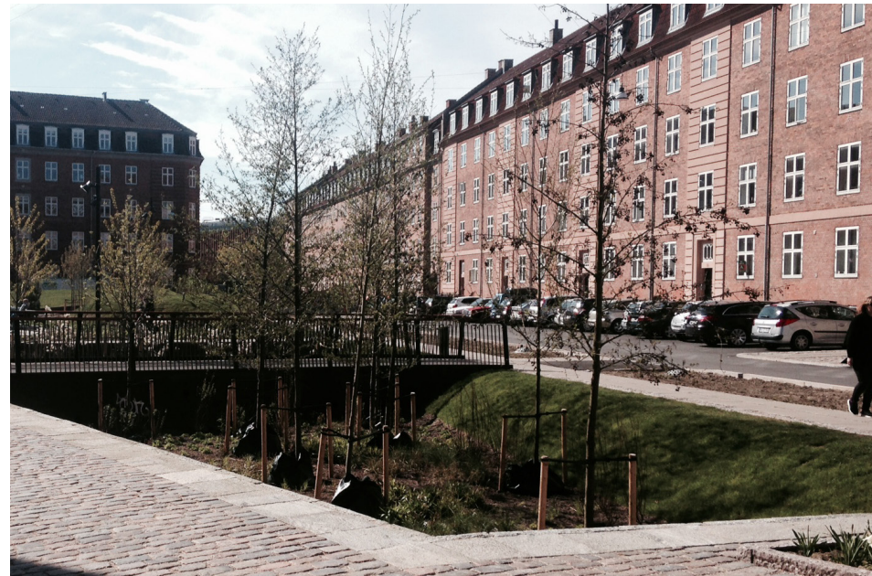
Exempel på en nedsänkt grönyta med både slänt och raka kanter vid Tåsinge plads, Köpenhamn.
