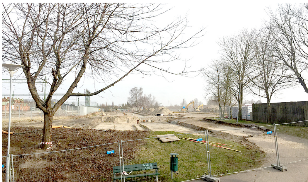
Mot planområdet från söder med pågående markarbeten. I bildens vänsterkant syns spårområdet och stationsbyggnaden. April 2018.
