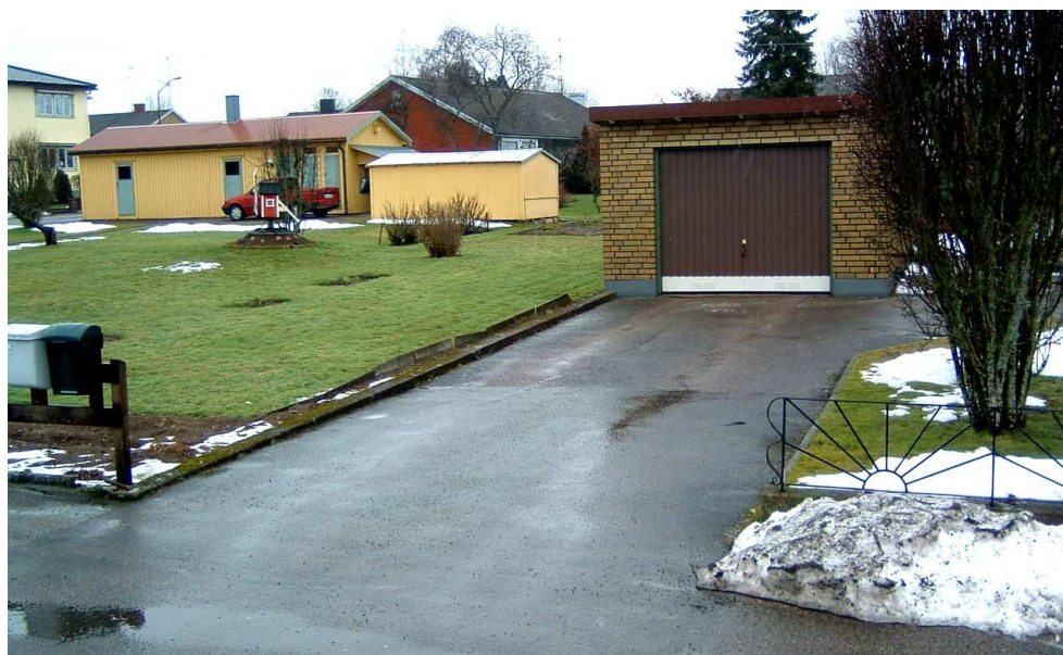
Uthusbyggnader på Kv S:t Göran
