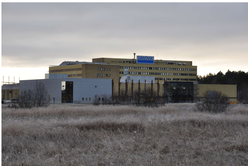
Coromants kontor och forskningslokaler sett från östra infarten
