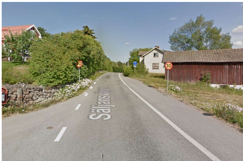
Passagen seende från västlig till östlig riktning.
