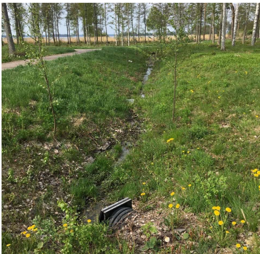
Föreslagen dagvattenhantering. Foto taget strax sydöst om planområdet vilket illustrerar det befintliga diket för fördröjning och rening av dagvatten.
