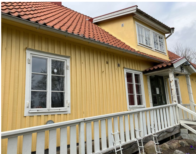
Byggnadens fönster är utåtgående träfönster med fast spröjs och mittpost.
