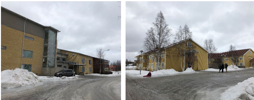
Figur 11. Delar av den befintliga bebyggelsen inom planområdet. T.V: Vämnäsby Äldrecenter fotat från söder (Nygatan). T.H: Befintliga byggnader där detaljplanen möjliggör för bostäder, fotat söderifrån.
