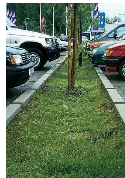
Dagvattnet perkolerar genom parkeringsytan ner till underliggande mark.
