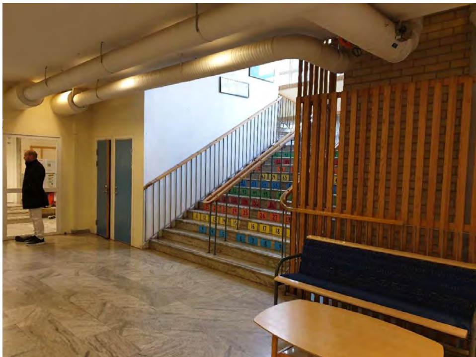
Släbroskolan, trapphus med tillägg (wc, hiss, installationer)
