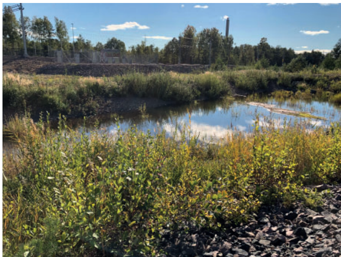
Befintligt dagvattenmagasin söder om Löfbergs lager
