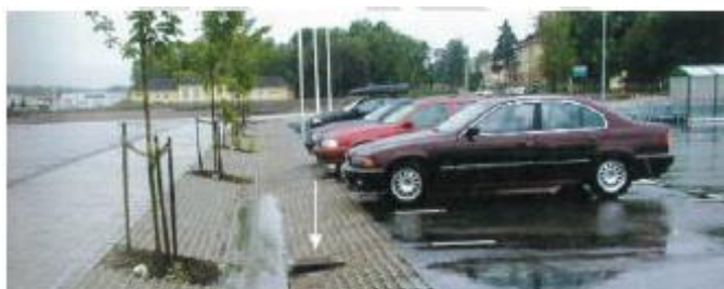
Infiltrationsstråk i samband med parkering
