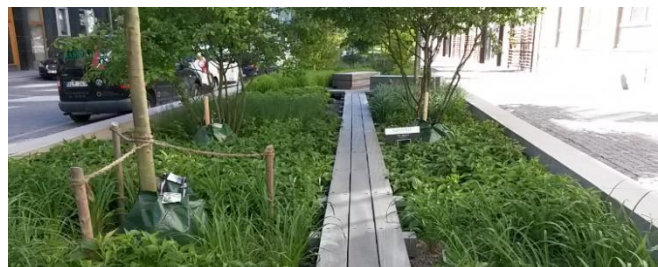
Biofilter/raingarden med träd
