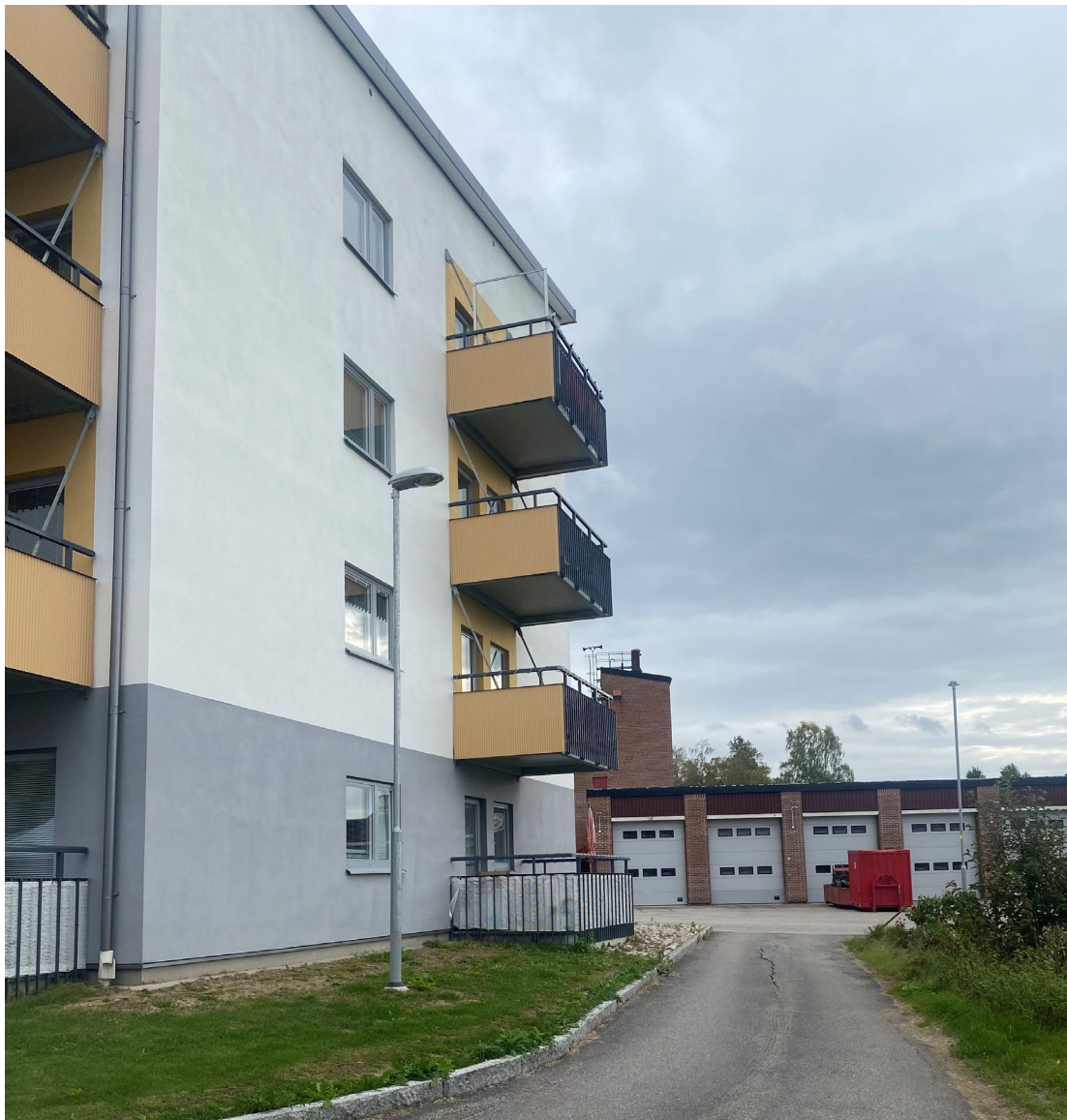
Figur 2: Ny byggnad norr om planområdet
