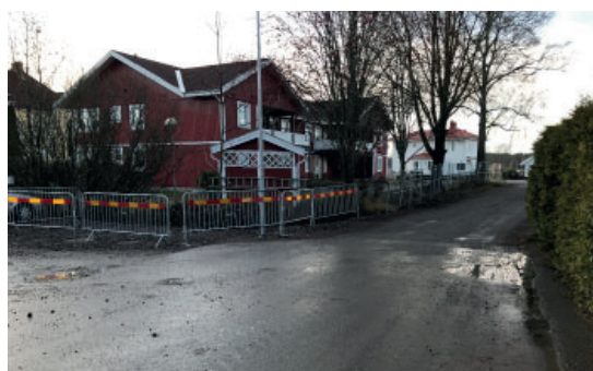
7. Flerbostadshuset strax norr om f d skolbyggnaden
