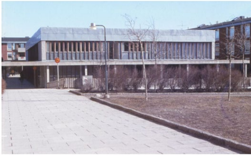
Fritidsgårdens ursprungliga uppförande, västra fasaden.
