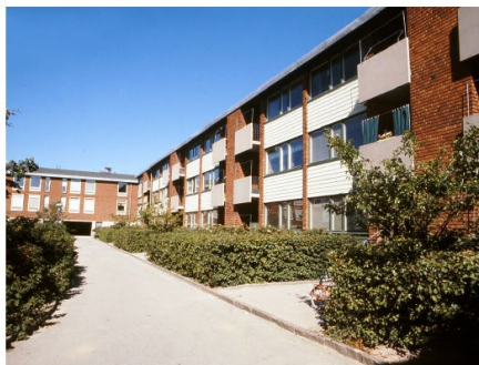
Flerbostadshus under 1970-talet. På bilden syns panelpartier och gröna fönstersnickerier. De ursprungliga balkongfronterna finns kvar. I fonden syns en överbyggd gång. Källa: Digitalt museum.
