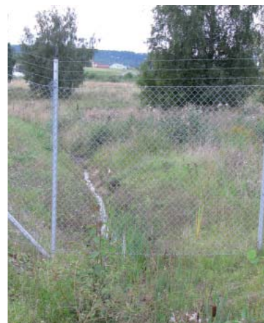
Befintligt dike längs Garnisonsvägen
