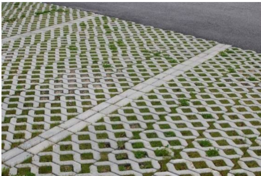
Figur 49. Exempel på genomsläpplig beläggning med hålsten.
