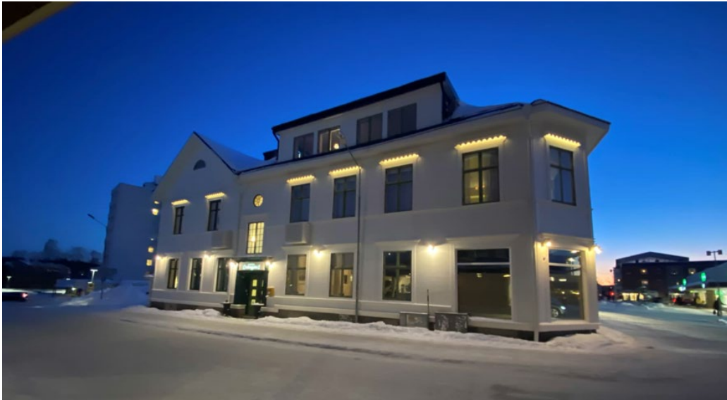
Figur 2. Den befintliga byggnaden på fastigheten Poppeln 3. Visar fasad mot nordöst och Färgaregatan.
