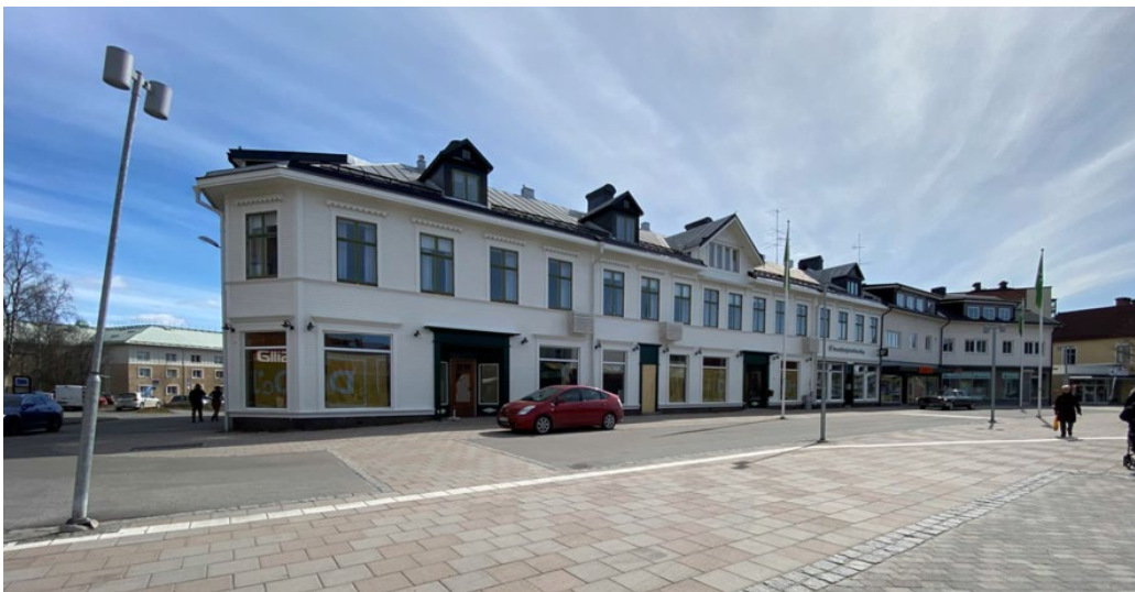
Figur 3. Den befintliga byggnaden på fastigheten Poppeln 3. Visar fasad mot nordväst och Drottninggatan.
