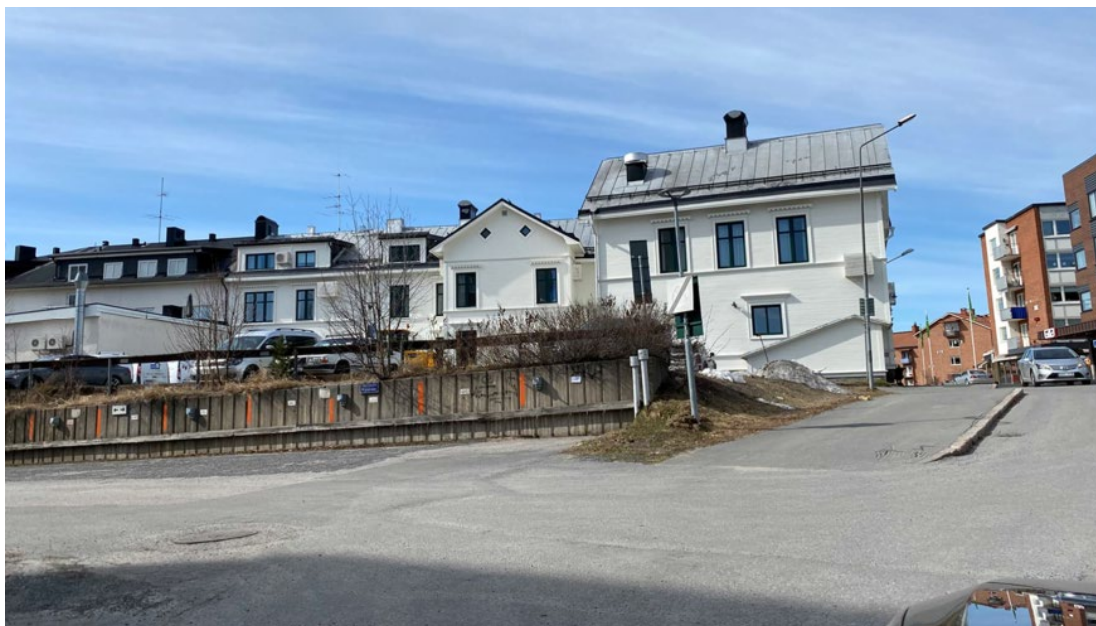
Figur 4. Den befintliga byggnaden på fastigheten Poppeln 3 med innergården på baksidan. Visar fasad mot syd.
