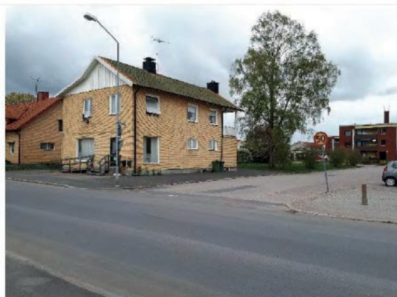
Befintlig bebyggelse inom fastigheten Dalhem 1
