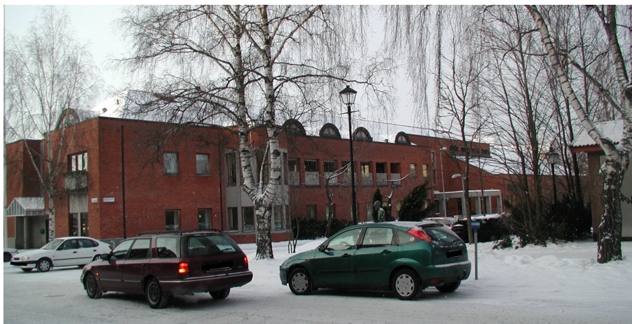
Befintlig byggnad sett från nordöst, Västra Ringgatan.
