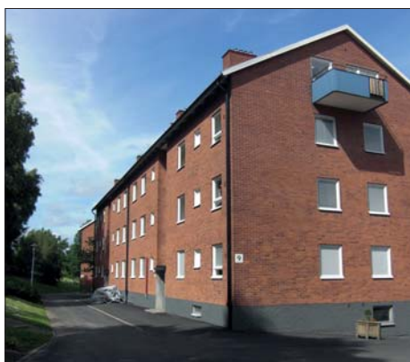
Befintlig bostadsbebyggelse, Kv Gnejsen
