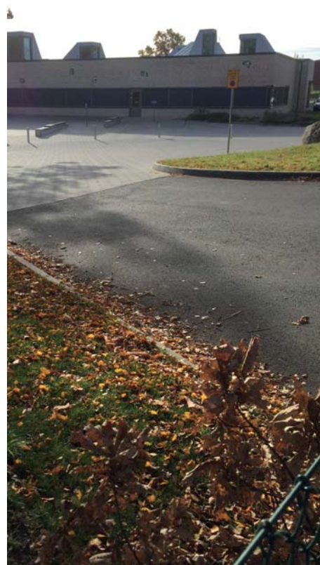
Befintlig skolbyggnad sett från Norra Bergvägen vid angöringen till skolan
