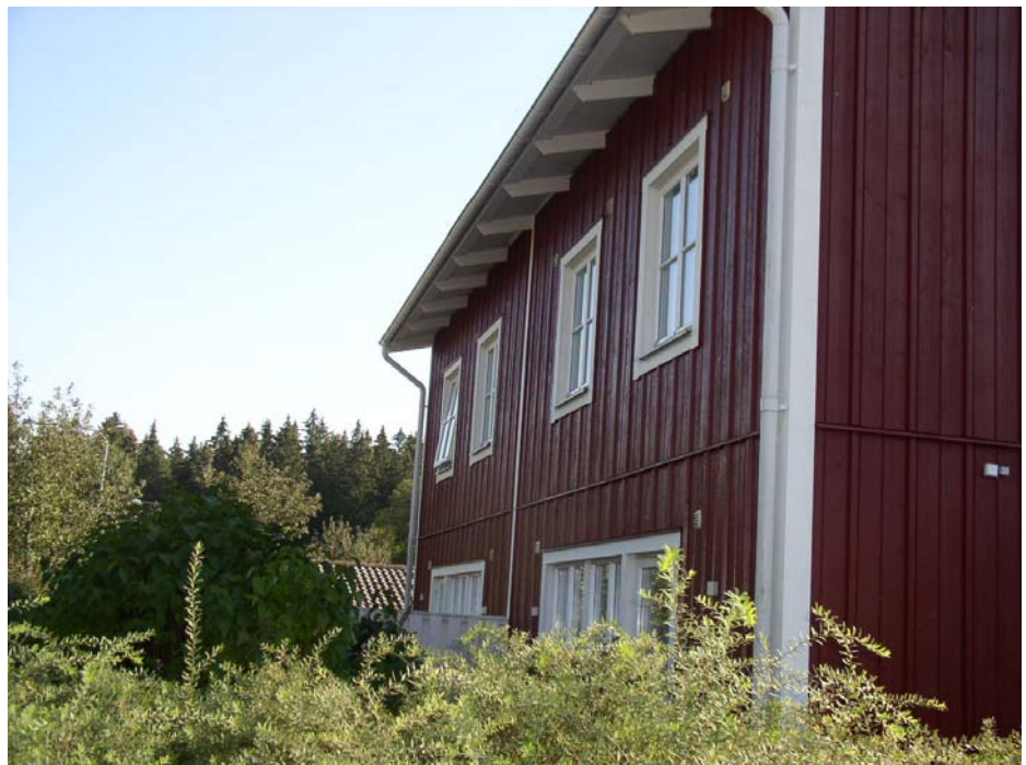
Baksida på parhus uppfört i två våningar, utan tillbyggnad.
