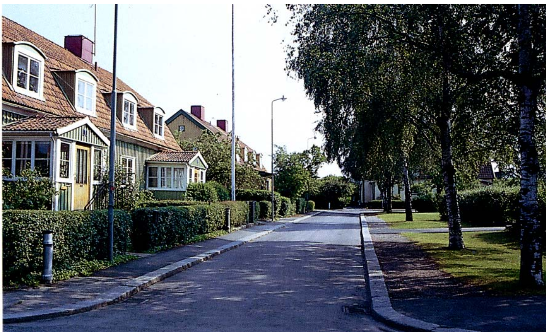
Figur 13. En blandning av låga hus är typisk för den svenska trädgårdsstaden. Här små dubbelhus vid torget Fågelsången, Oxelbergen i Norrköping. Arkitekt: S.E. Lundqvist, 1919.
