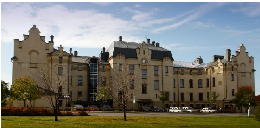
Figur 5: Östra skolan, Hudiksvalls kommun.
