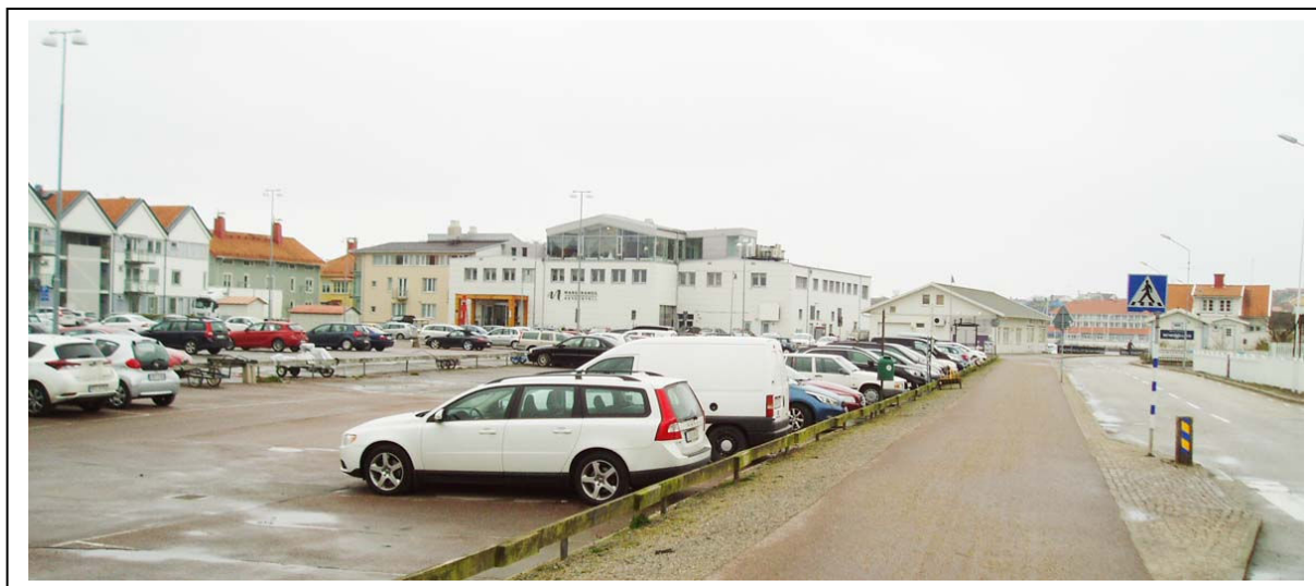
Vy från öster med befintliga bostadshus i 3 våningar till vänster och Havshotellet i bildens mitt
