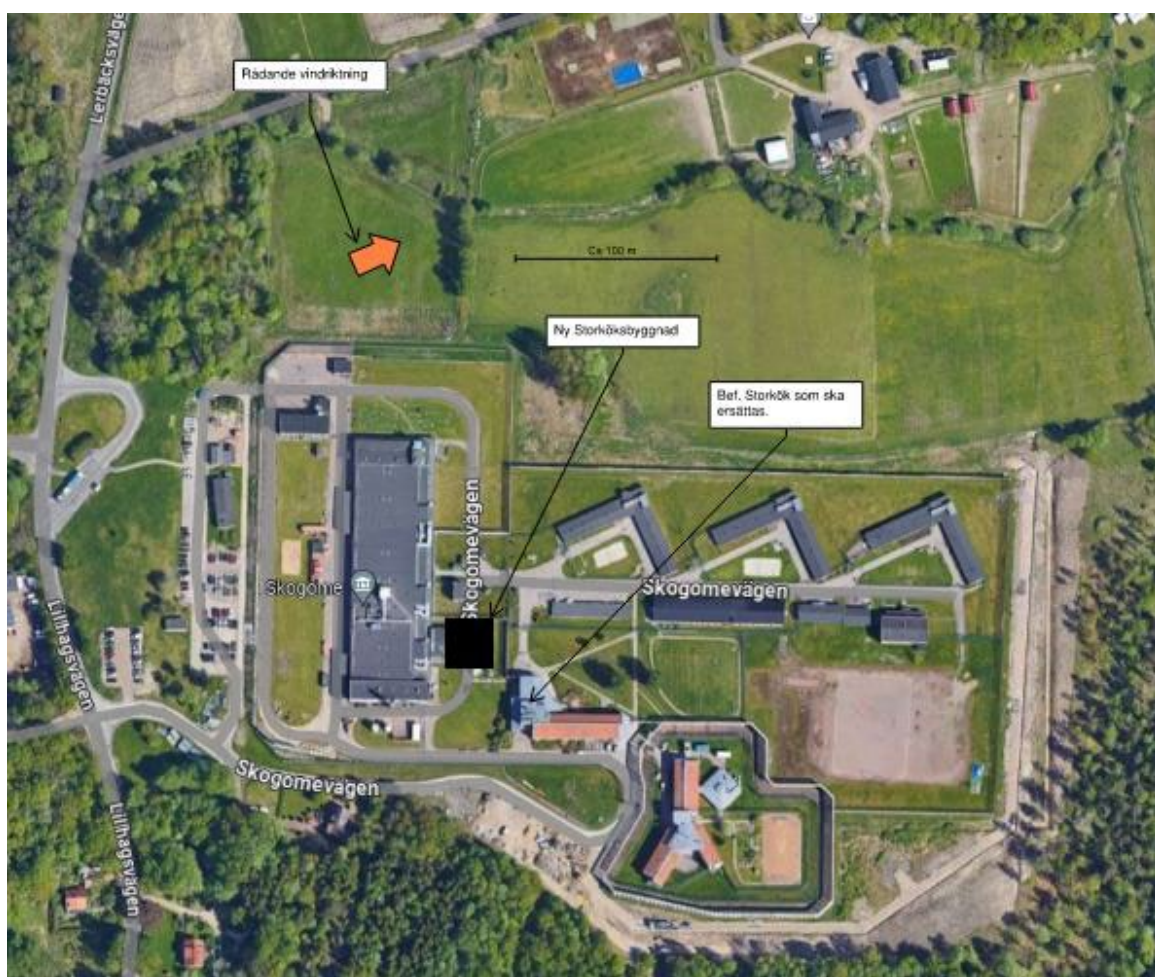
Figur 29: Flygbild där nytt och befintligt storkök pekas ut tillsammans med vindriktning.
