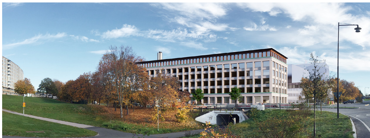
Vy över planerad anläggning från Viksjöleden
