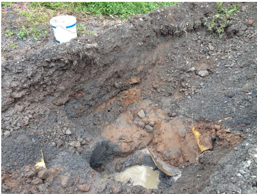
Foto 1: Provgrop i provpunkt 14GP08 längst ledningsgraven. Vattnet i bild är markvatten från ledningsgraven, och inte grundvatten.
