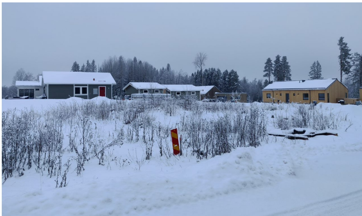
Bild på delar av bebyggelsen i etapp 1.
