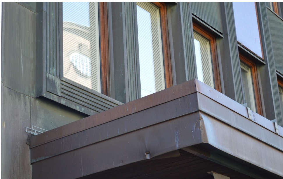
Fasaddetaljer på Folksamhuset. Bearbetat fasaduttryck i ärgad plåt, troligtvis koppar. Foto: Värmlands museum.
