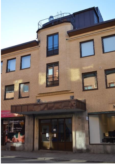
Takfoten sticker ut och döljer helt takfallet från gatan. Under finns en profilerad takfot i tegel med en kopparplåt ovanpå. Takfoten markerar tydligt byggnadens avslut och är ett viktigt karaktärsdrag. Foton: Värmlands museum.
