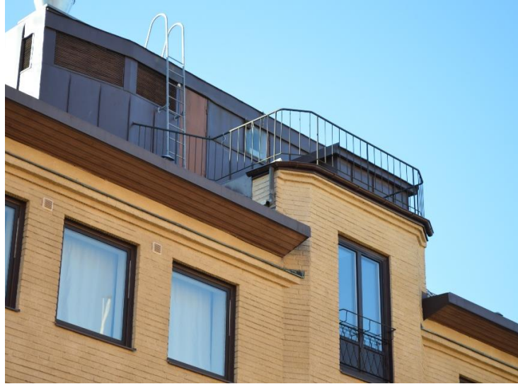
Takfoten sticker ut och döljer helt takfallet från gatan. Under finns en profilerad takfot i tegel med en kopparplåt ovanpå. Takfoten markerar tydligt byggnadens avslut och är ett viktigt karaktärsdrag. Foton: Värmlands museum.
