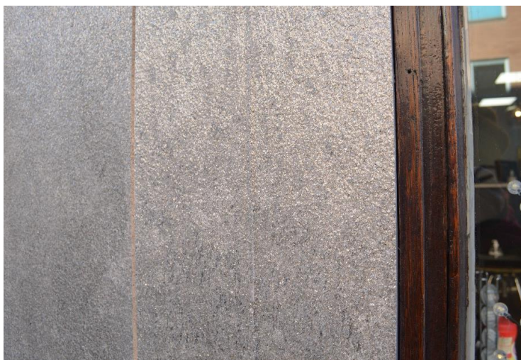
Bottenvåning mot Herrgårdsgatan. Bottenvåningen är klädd i glimmerskiffer, vid entréer till trapphus är naturstenen behandlad på olika sätt. Butiksfönstrens träkarmar är original. Foton: Värmlands museum.
