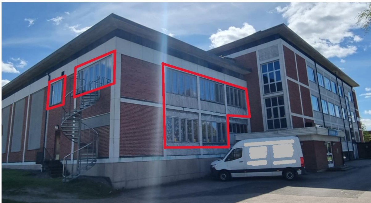
Bild 5 och 6. Inom röd markerat område på bilden ovanför visas de befintliga metallfönster med rundade hörn som ska bibehållas till sin utformning. Bild 6 till vänster visar fönsternas utformning med träkarm på insidan.
