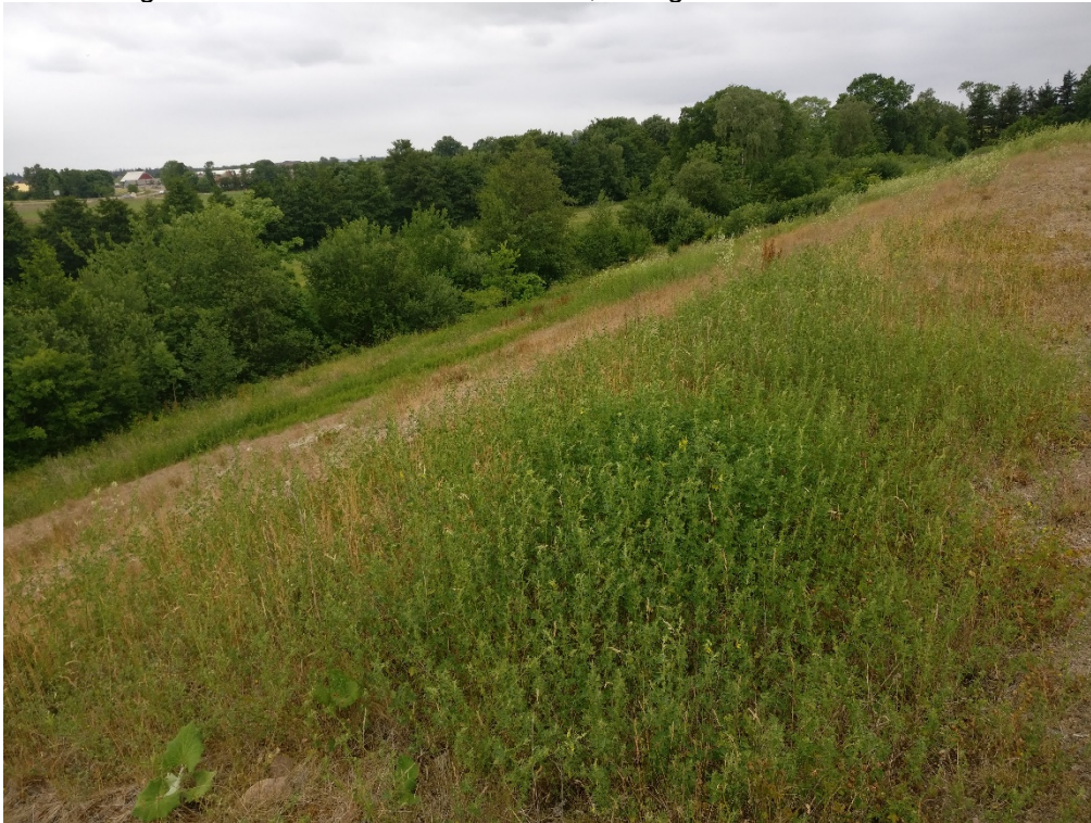
Figur 2. Befintlig slänt i områdets södra del, mot Vadebäcken. Foto: Alexander Berglin, Sigma Civil AB
