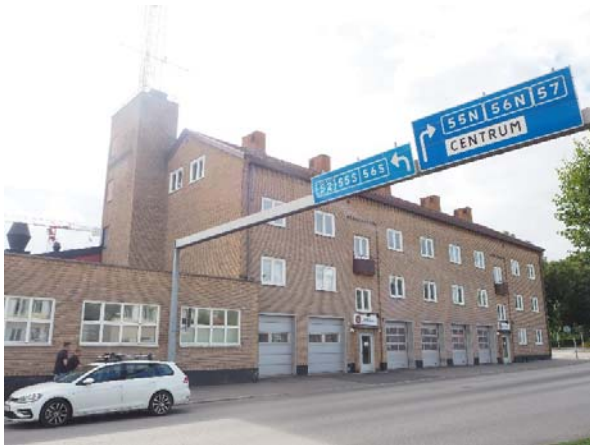
Brandstationen sedd från Djulögatan
