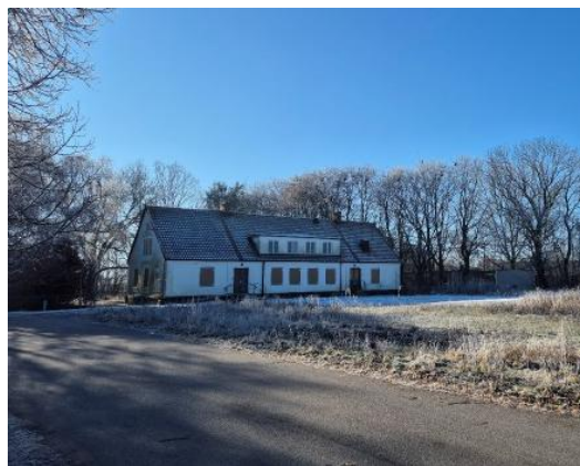
Arvidsborgsgårdens fasad mot norr
