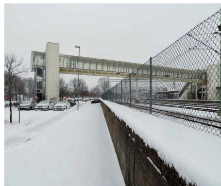
Befintlig mur mot rangerspårområdet. Här sedd ifrån norr.
