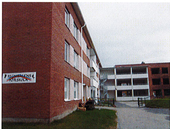
Före detta bostadshus i norra delen, ett under rivning
