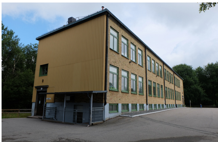
Byggnad A. Bild på befintlig huvudbyggnad, tidigare folkskola. Byggnaden är från 1947.
