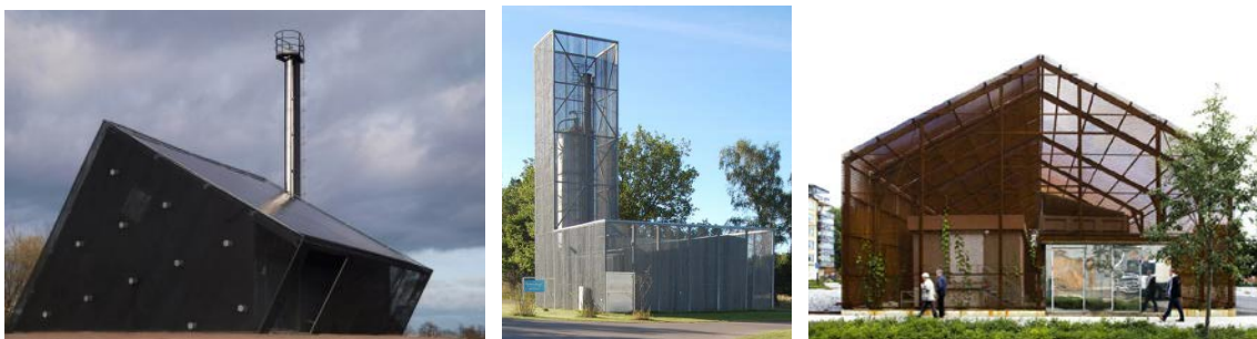
Exempel på välgestaltade teknikbyggnader. Till vänster och mitten: Fjärrvärmecentraler utformade med nätstängsel, arkitekt: Strindberg Arkitekter. Till höger: Ställverk i Uppsala, arkitekt: White.
