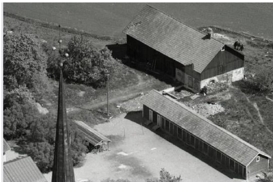
Bilden visar den nu mera rivna ekonomibyggnaden på platsen för planförslaget. Inspiration: Gavelmotiv/sadeltak, sockelvåning i sten eller betong och övervåning i trä. Hämtad ur kulturmiljöutredningen
