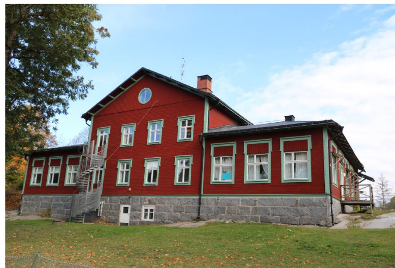
Romfartuna skolas västra fasad idag. Bild: Norconsult AB.
